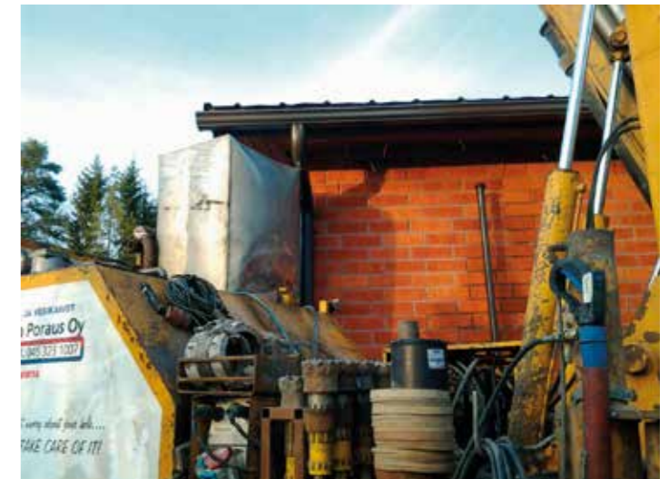
Ajoreitin korkeus ei riitä. Vesisäiliö ottaa kiinni ränniin.
