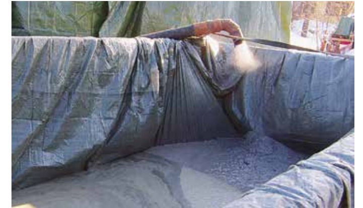
Kivituhkan purku lavalle. Kivituhka on porausvaiheessa savimaista.
