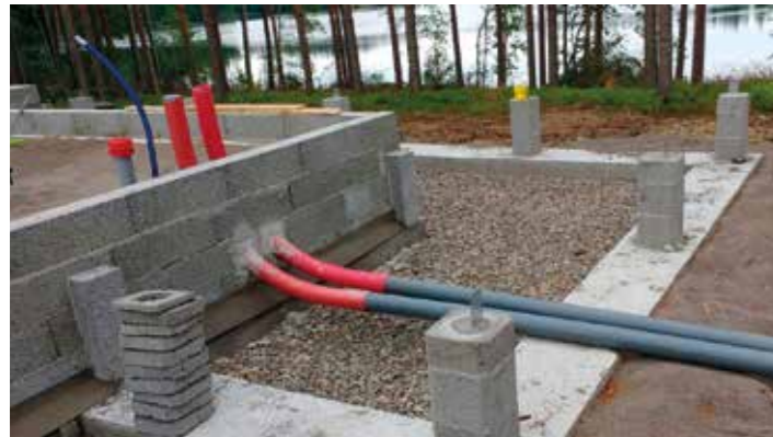
Oikein tehty läpivienti
