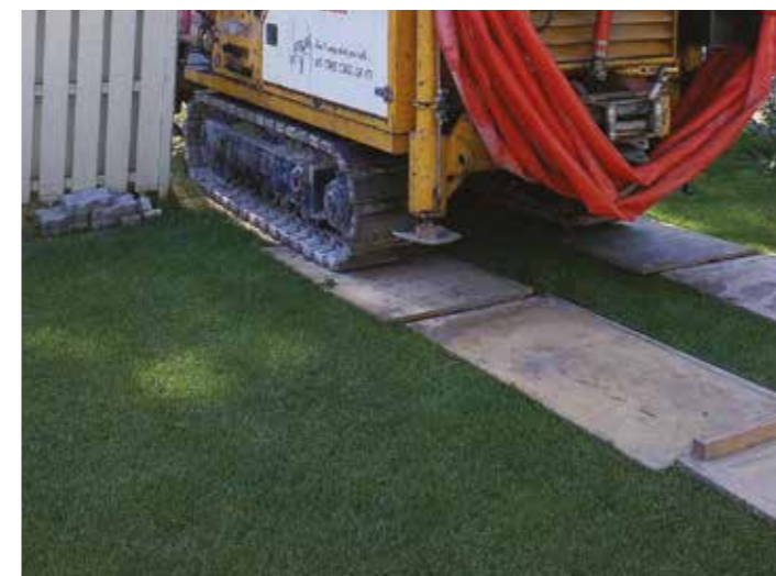
Poraus koneen telojen alla voidaan käyttää vanerisuojuuksia, jolloin jälkiä ei juuri jää nurmelle.
