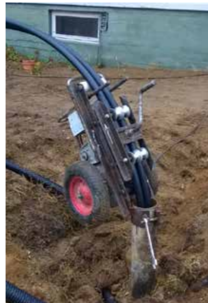
Lämmönkeruuputket (kollektori) lasketaan kaivoon laskukoneen avulla, joka vaatii toimiakseen sähköä
