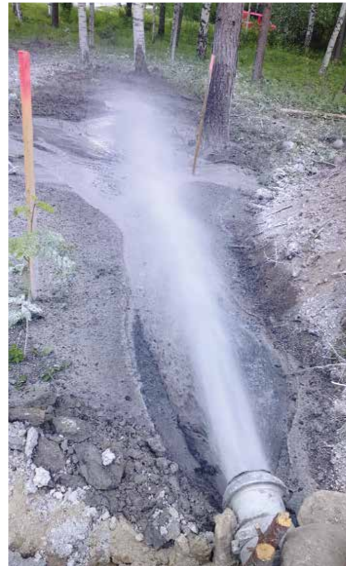
Kivituhkan purku tontille. Vapaata aluetta tarvitaan noin 3x15 m.
