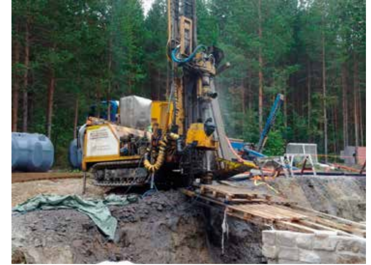
Virheellinen porauspaikan sijoittelu. Porari joutuu tekemään itselleen porauspaikan koneen eteen montun takia. Jos porauspaikalle kaivetaan monttua etukäteen, tulee kaivannon olla riittävän iso koneelle ja porarille.
