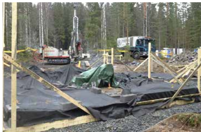
Sopiva ajoitus lämpökaivon poraukseen rakennustyömaalla.
