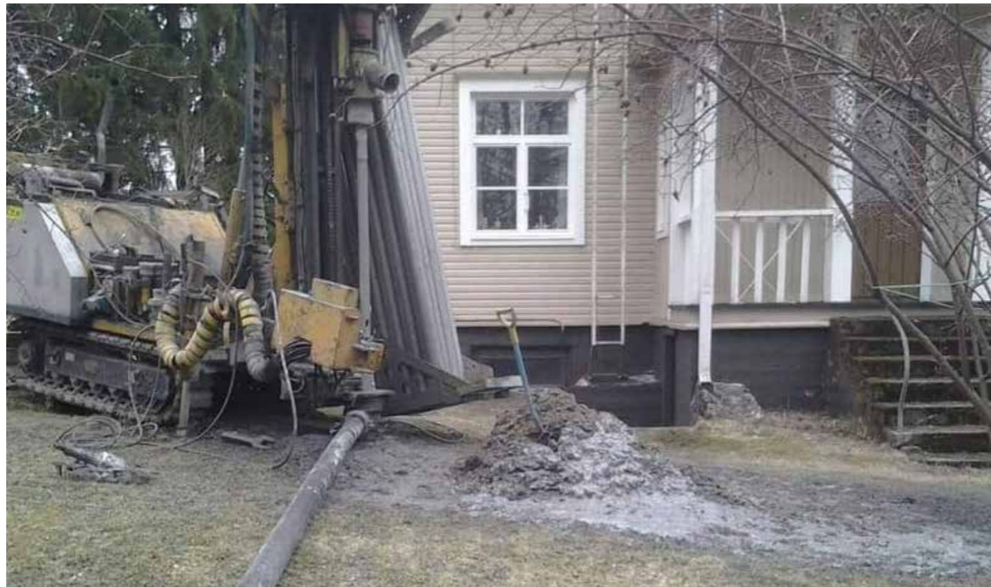
Pitkän maaporauksen porausjäte lapioitu kasaan
