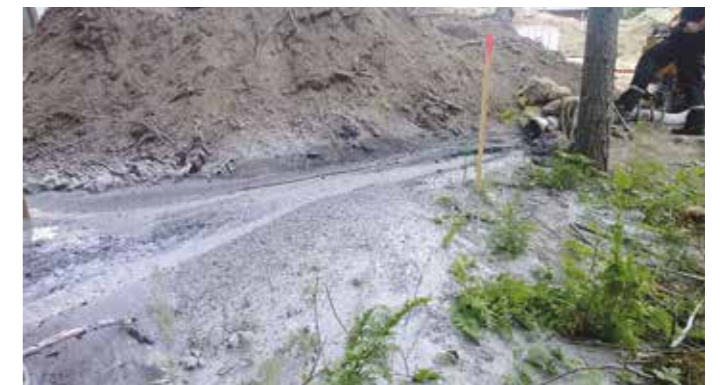
Purkupaikka porauksen jälkeen
