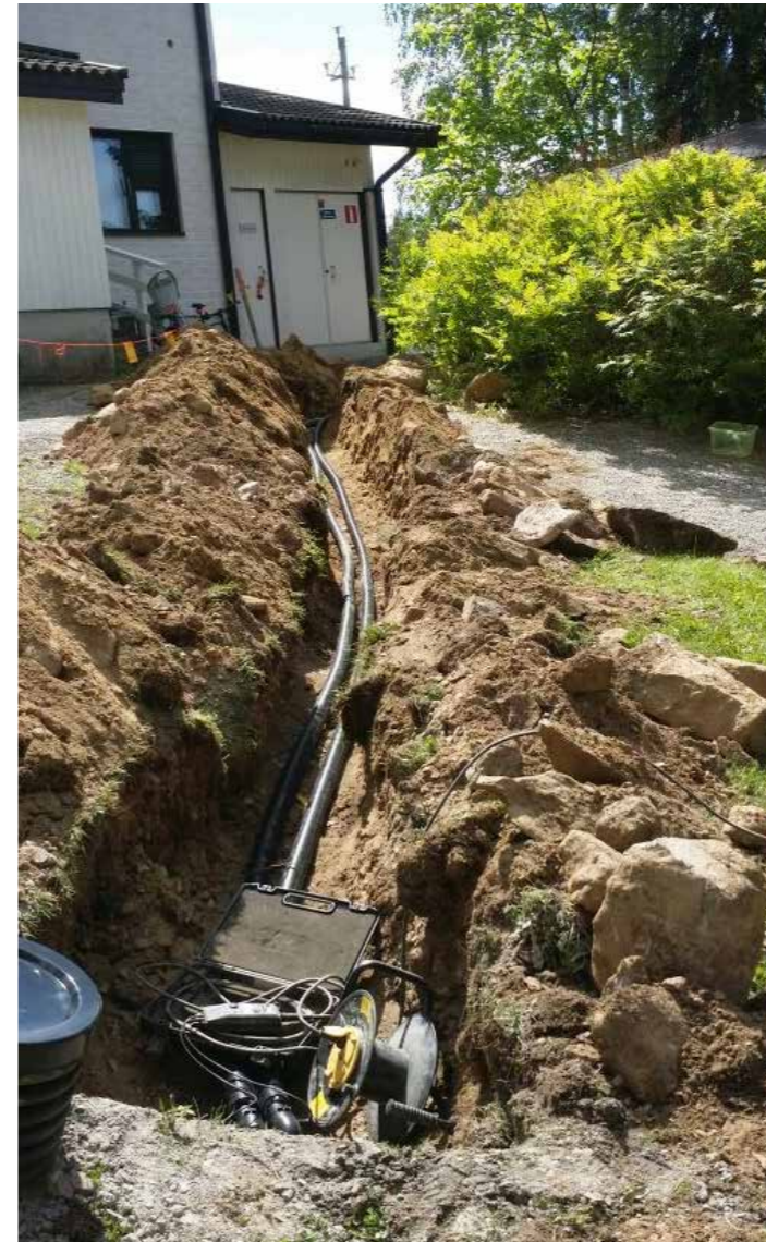
Vaakakaivuu kaivolta talolle. Huomioi riittävä lasku kaivolle. Kaivon jäädessä ylemmäksi kuin maalämpöpumppu, joudutaan asennuksessa käyttämään ilmauskulmia, jotta mahdolliset ilmataskut poistuvat järjestelmästä.
