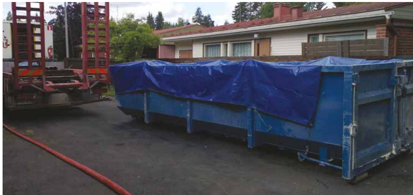
Vaihtolava on suojattu pressulla, jotta kivituhkapöly ja vesisumu ei leviä naapurin tontille. Huomioi myös riittävä kokoluokka lavalle (5500mmx2500mmx1200mm). Matalareunaiset rahtilavat eivät käy kivituhkan purkuun. Mikäli purku tehdään matalareunaiseen rahtilavaan, porausyrittäjä ei vastaa miltään osin pihan siivouksista ylilaitojen yli tulleista porausaineksista ja vesimassoista.
