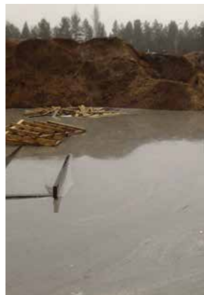
Vesimäärä vaihtelee riippuen onko alueella paineellinen pohjavesi.
