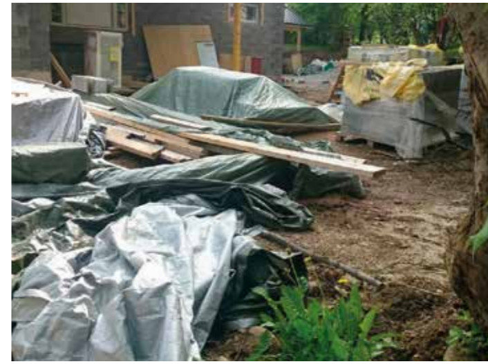
Ajoreittiä ei ole raivattu valmiiksi. Muista huolehtia, että porauspaikalle on esteetön kulku!
