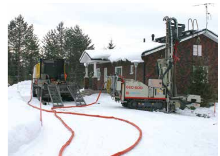
Poraus pakkasraja talvella on -15 astetta. Talvella on estettävä lumien tippuminen katolta porauspaikalle.
